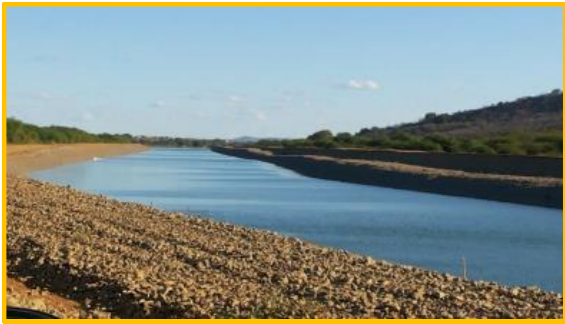
Captação de água do Eixo Norte
