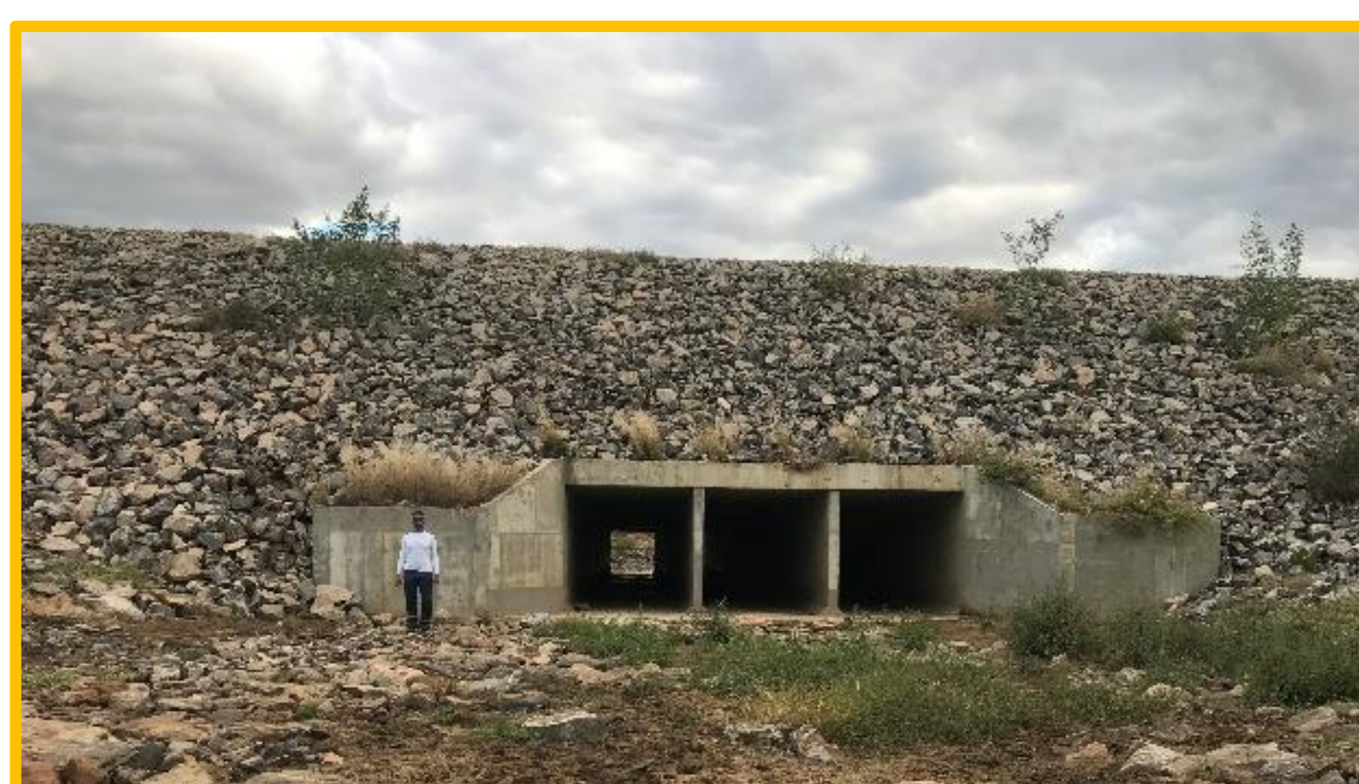
Bueiros / passagens de fauna
