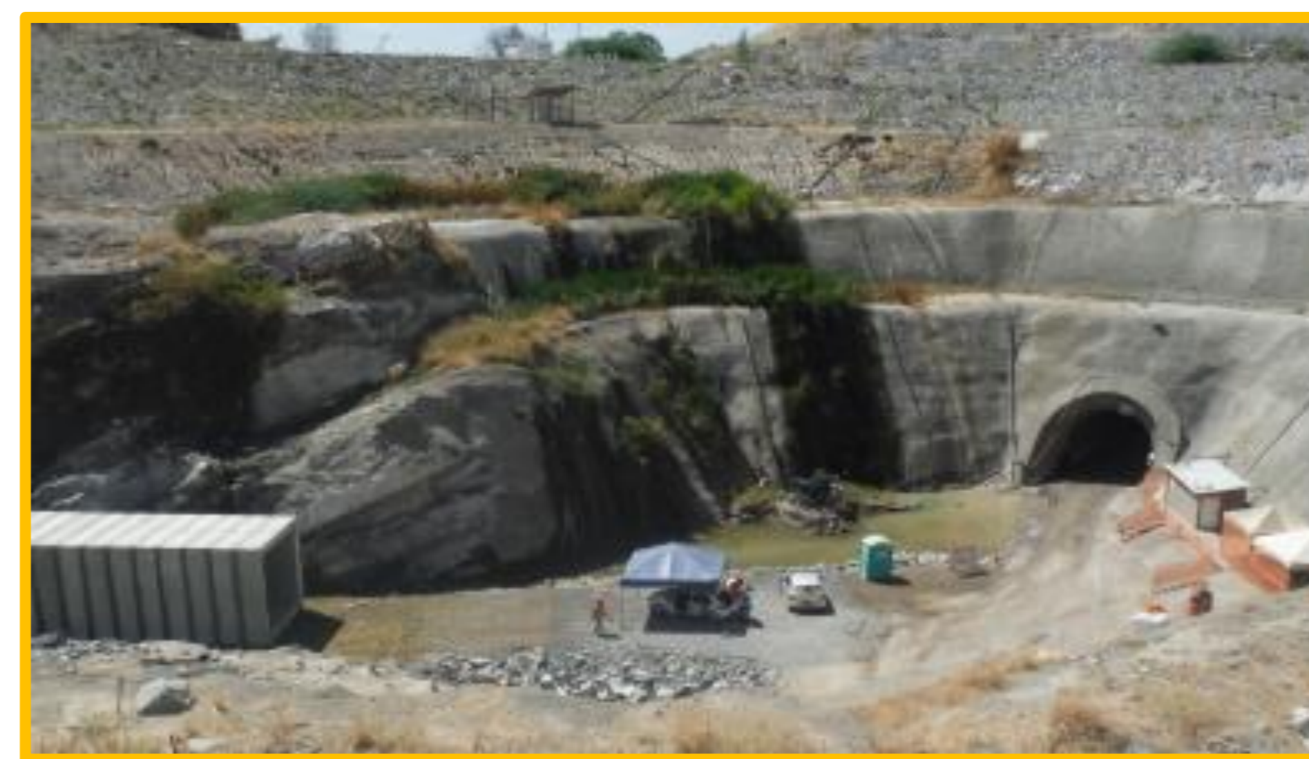
Desemboque do Túnel
