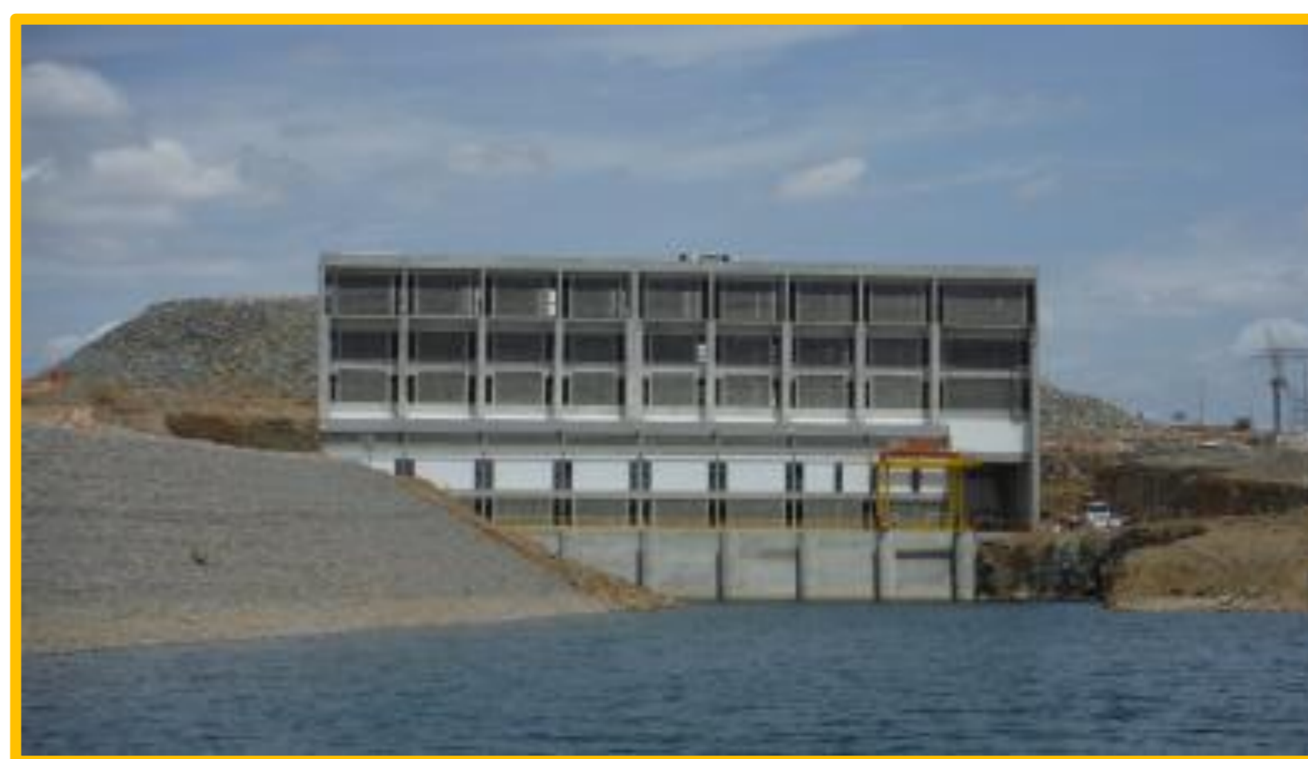
Estação de Bombeamento 1 do Eixo Norte
